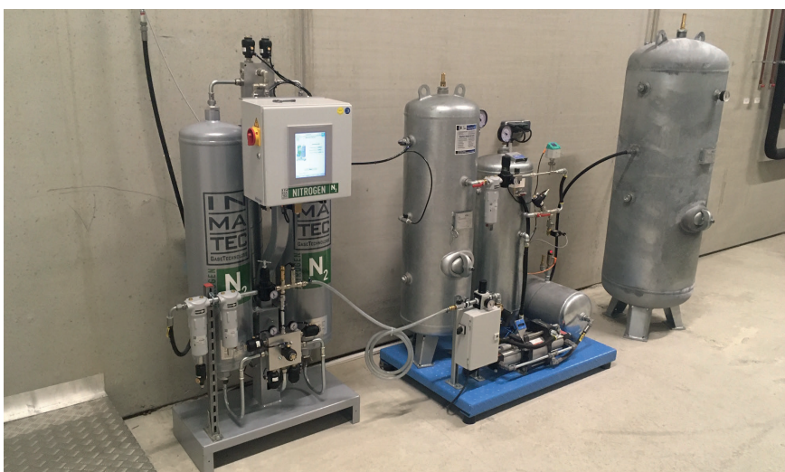
Bild 2. Stickstoffgenerator der Firma Inmatec (ganz links). Der Tank auf der Plattform rechts daneben ist der Produkttank (150 l), in den der Stickstoff nach der Erzeugung zunächst mit 6 bar eingebracht wird. Das zweite Modul auf dieser Plattform ist das Verdichtersystem. Der große Tank rechts ist der Pufferspeicher (500 l), in dem N 2 mit 25 bar gespeichert wird. Von hier geht die Leitung zu den Spritzgießmaschinen © Pollmann International
